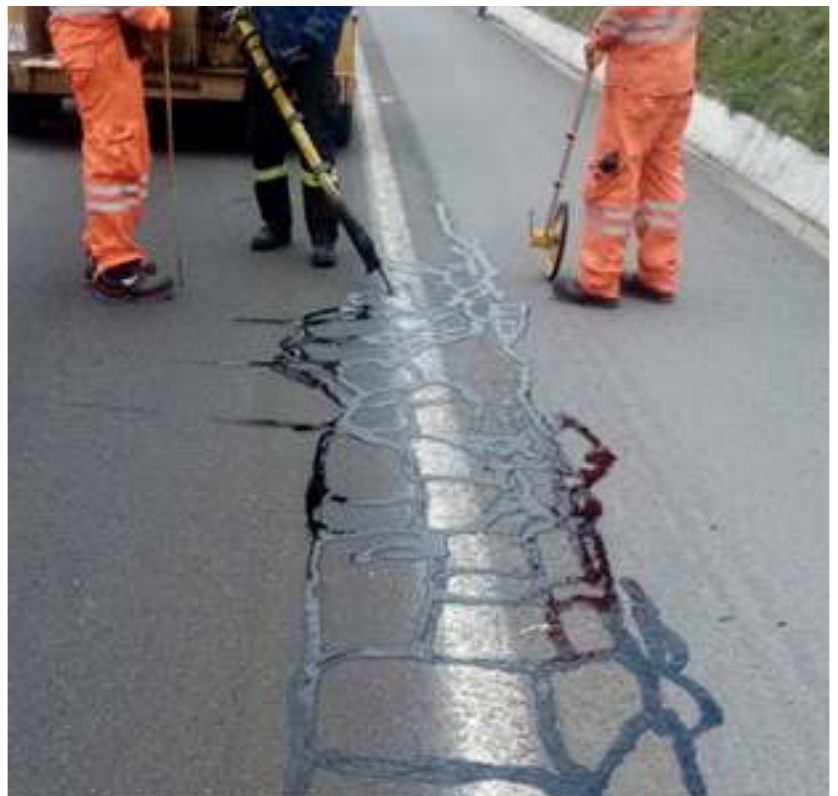
Sellado de Fisuras en Pavimento Flexible (Tipo Puente)
