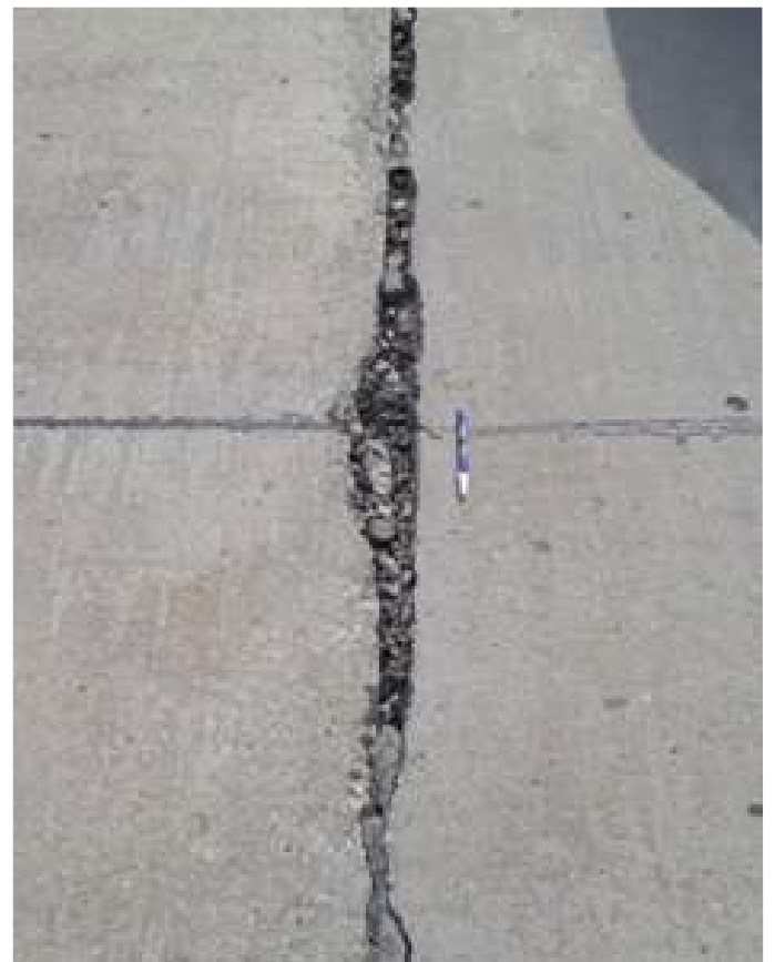
Falla en Junta, acumulación de material incompresible
