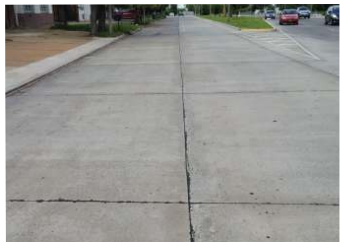
▲ Pavimento Rígido de Hormigón
